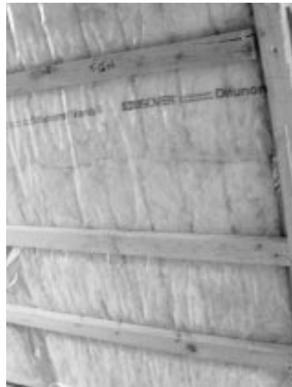
写真13 屋根裏に用いられた吸放湿・防湿シート
