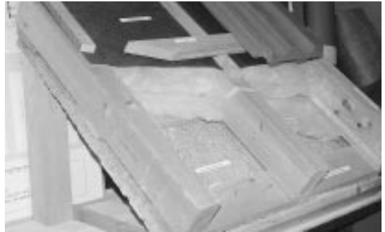
写真12 屋根構造内に設置された透湿防水膜とリサイクルセルローズファイバー断熱材
